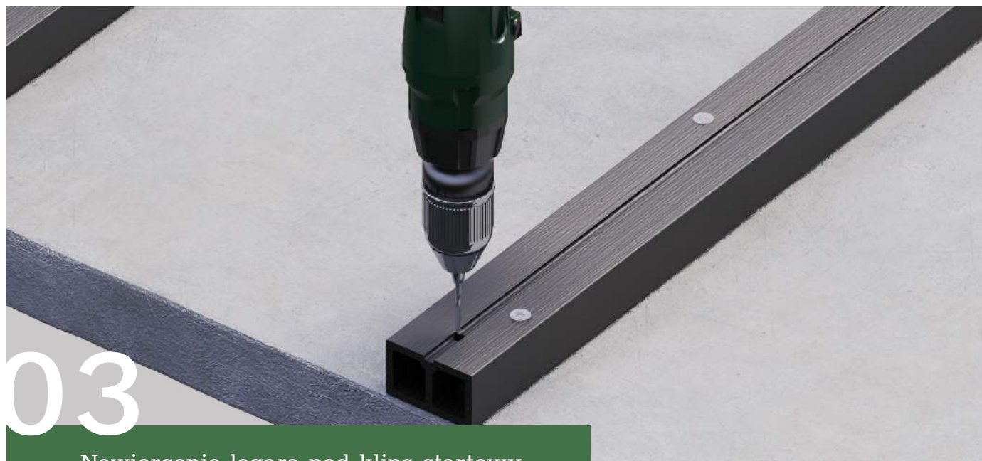
Nawiercenie legara pod klips startowy
