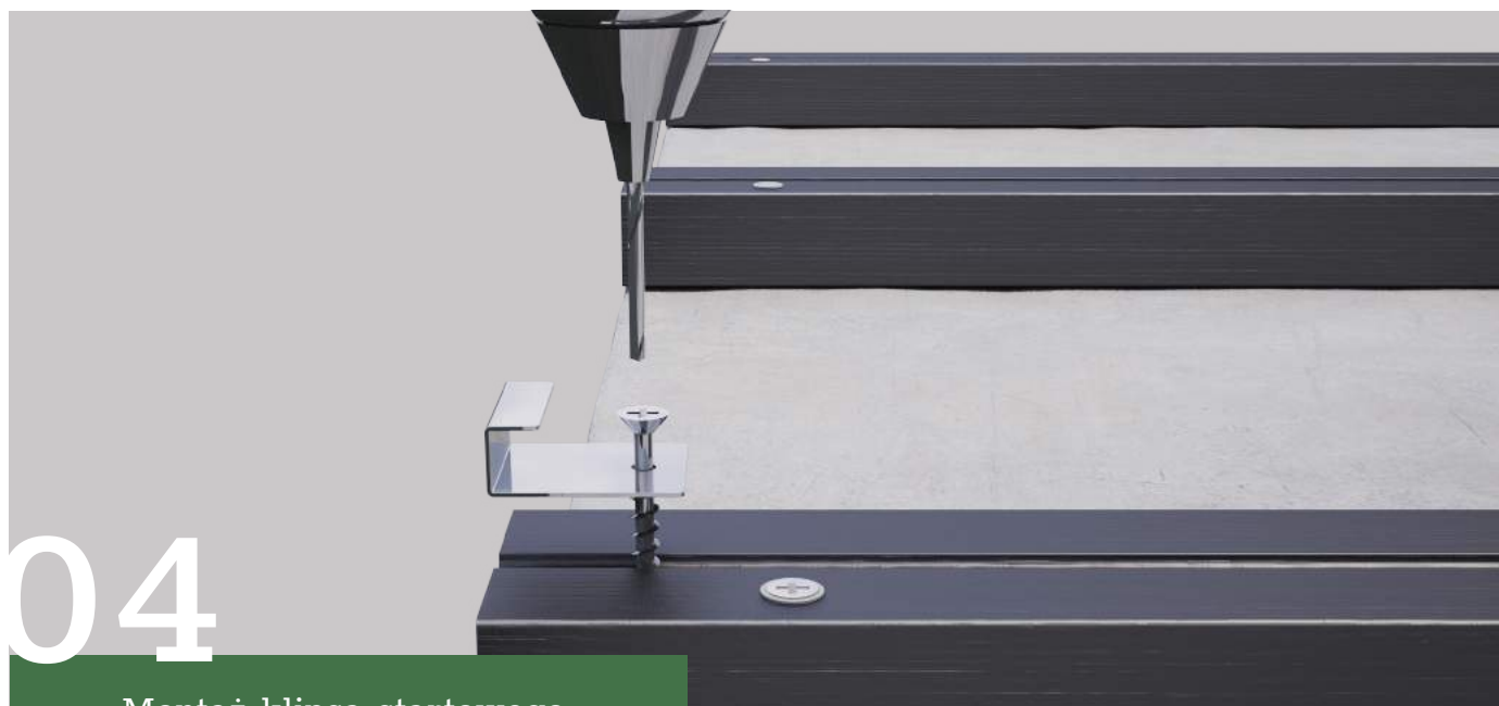
Montaż klipsa startowego
